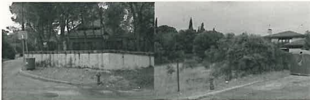
Hidrantes en la Avenida de La Berzosilla y en la Avenida Canto del Mirador
